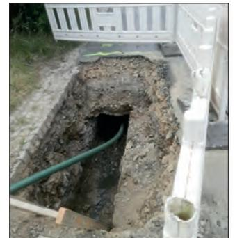
Wegen des desolaten Zustands der heutigen Trinkwasserleitung erfolgt zeitgleich das Verlegen einer neuen Trinkwasserleitung.
