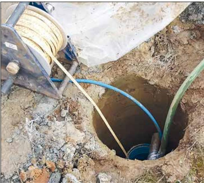
70 Meter reicht die im Durchmesser 30 cm große Bohrung in die Tiefe
